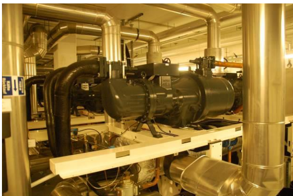
1 MW-os talajhőszivattyú az EnBW székházban és begyepesített zöld tetők
