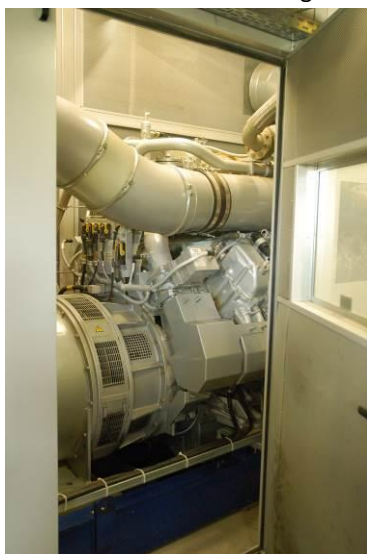
Az MTU gázmotor, az 1 MW-os ellenállás terhelés és a túlfeszültség védelem
