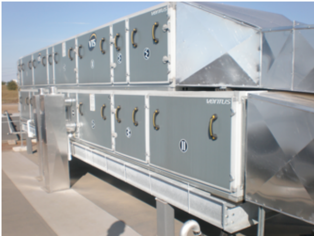
Fig. 7.36 Heat recuperator
