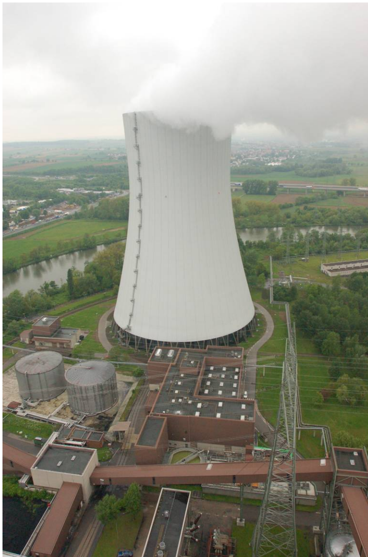
8. kép: Széntüzelésű erőmű hűtőtornya Heilbronnál
